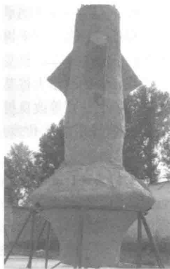
图 1.2-3 挤扩支盘桩实桩图
