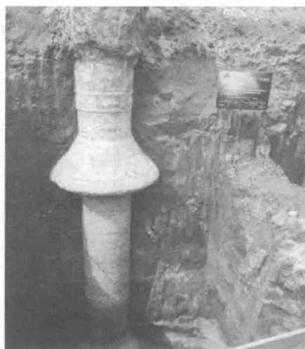
图 1.1-6 钻扩多盘桩实桩图
