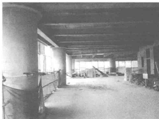
图 1-4 圆钢管混凝土柱
