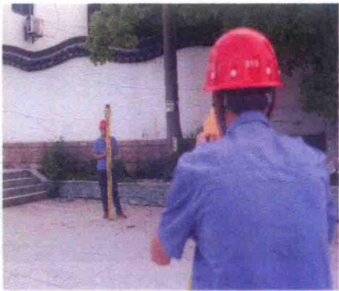
图 1-1-5 地上高程控制测量
