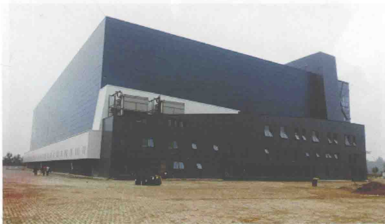
图2 2013年完工的北京京津港冷链物流冷库的外形
