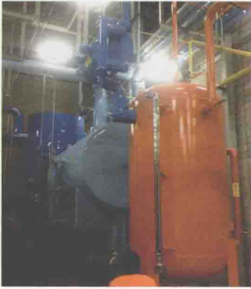
图 8 低温低压循环桶（浅蓝色）与中温低压循环桶（深蓝色）的安装现场 (Lineage 公司, 2014 年完工, 美国)
