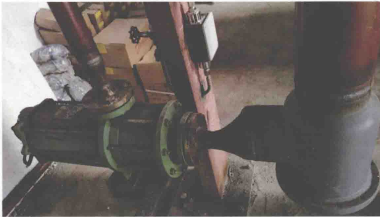
图6 解决制冷剂泵自动上液的管道阀门与泵的连接（在第6章有详细介绍）
