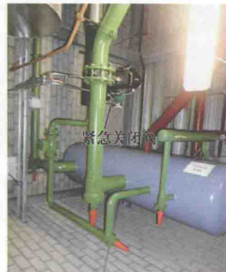
图 12 在高压贮液器出液管上的紧急关闭阀 (Diepop's-Hertogenbosch B. V., 欧洲)
