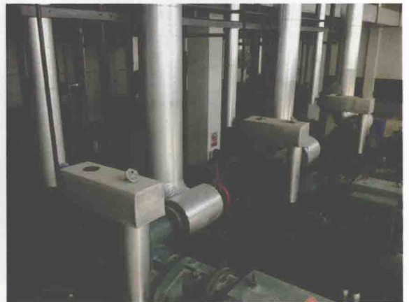
图4 山东中凯兴业贸易广场有限公司15万吨冷库压缩机采用闪发经济器补气连接
