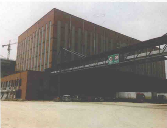
图3 2012年完工的山东中凯兴业贸易广场有限公司15万吨冷库
