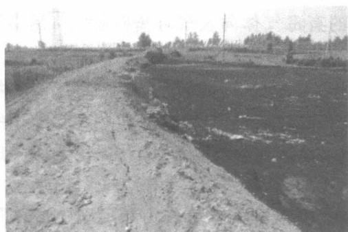
图 1-3 剩余污泥堆场简易坝体
