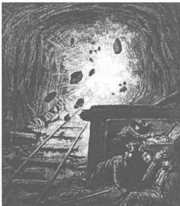
图 1-1 最早的钻爆法开挖隧道的工序
