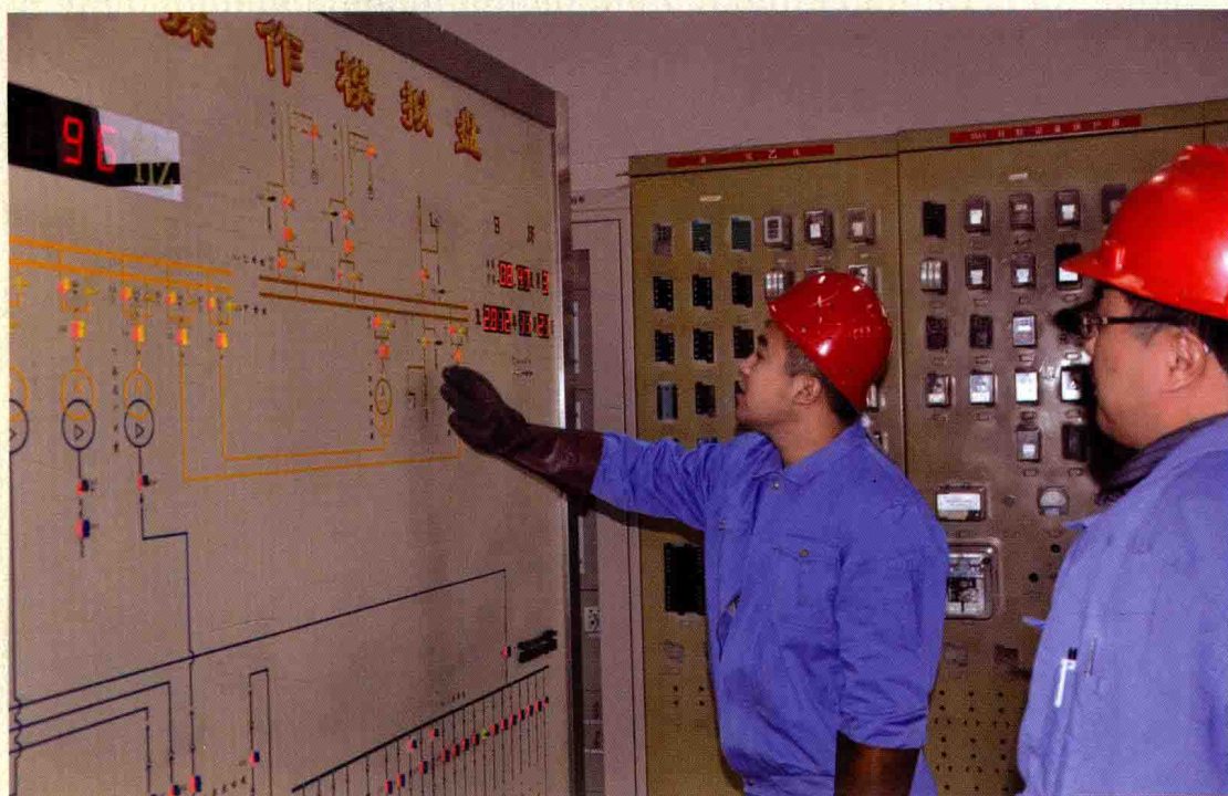
2014 年，公司非煤产业继续保持良好发展态势
