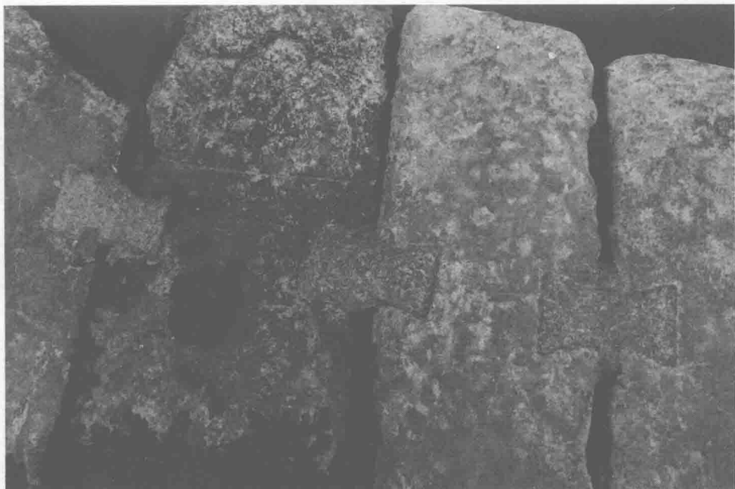
灵渠坝顶两石相接处各凿成“乂”形阴阳石槽，用熔铸生铁浆灌入后的历史遗迹。
