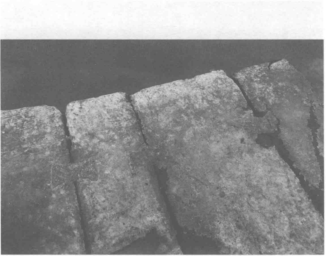
灵渠大坝上的“乂”形阴阳石槽
