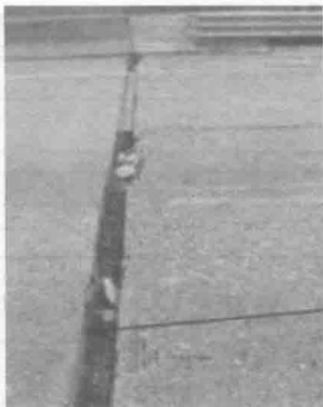
图 1-1-2 接缝料失效
