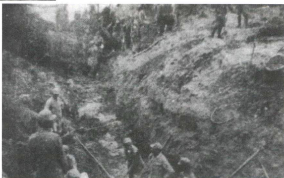
紧邻河水保留的一段河堤,待南面至低于河水时才最后挖开(左图)
