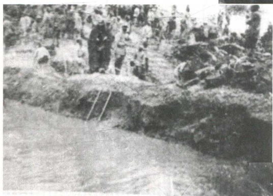
紧邻河水保留的一段河堤,待南面至低于河水时才最后挖开(左图)
