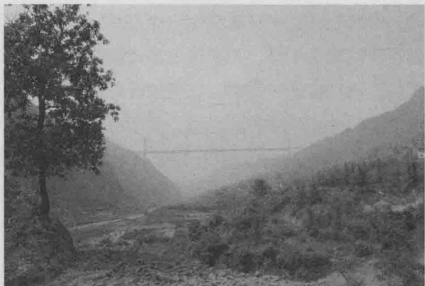
有亚洲第一大桥之称的关岭坝陵河大桥
