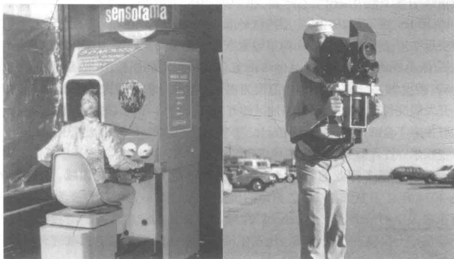
图 1-1 莫顿·海利希的 Sensorama 模拟设备
