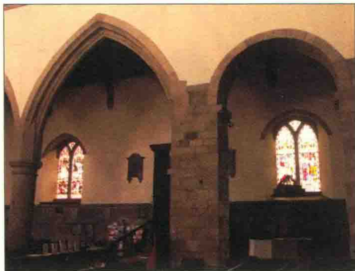
图1.3：撒克逊和诺尔曼砖瓦匠采用圆拱（图右）形式，但到13世纪早期，才采用更灵活的哥特式尖拱（图左）形式。注意，左边的柱子比中间的墩柱要薄，因为桁架和飞扶壁的运用意味着墙壁可以减小厚度。
