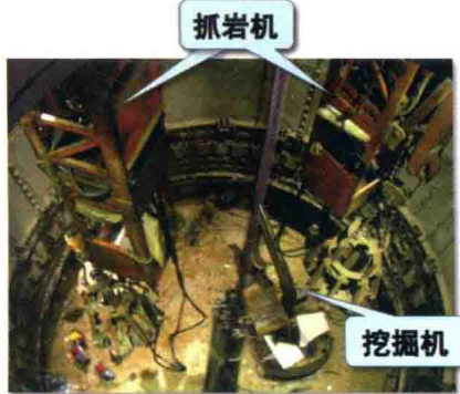
抓岩机、挖掘机协同装岩清底
