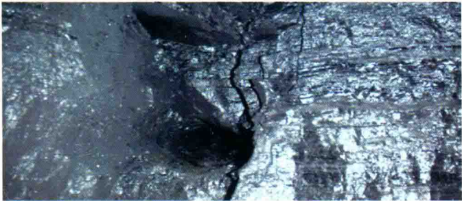
压裂钻孔附近的大型裂缝
