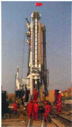
U 型井组施工现场
