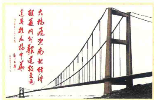
天堑变通途——江阴长江大桥
