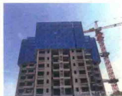
(d) 脚手架工程
