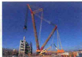
(c) 起重吊装及安装拆卸工程
