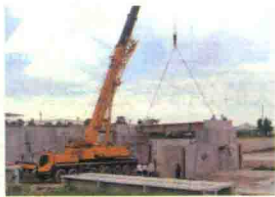
(c) 起重吊装及安装拆卸工程
