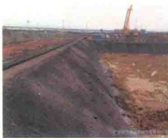
(a) 基坑支护
