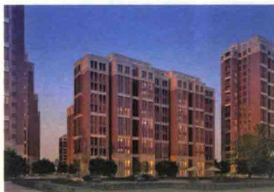
图 2.1 房屋建筑工程
