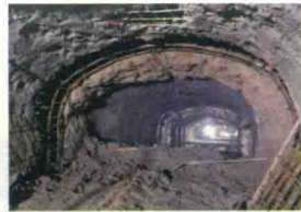
(f) 暗挖工程
