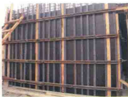
(b) 模板工程及支撑体系
