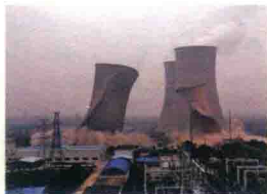
(e) 拆除、爆破工程
