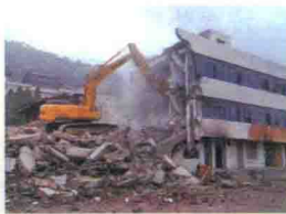
(e) 拆除、爆破工程
