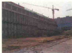
(a) 深基坑工程
