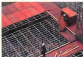
(b) 模板工程及支撑体系
