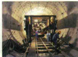
(f) 暗挖工程
