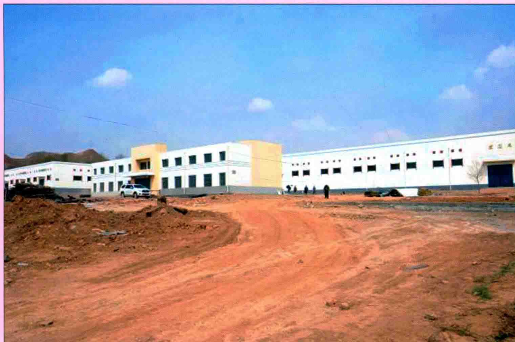
建设中的青海省实物地质资料库
