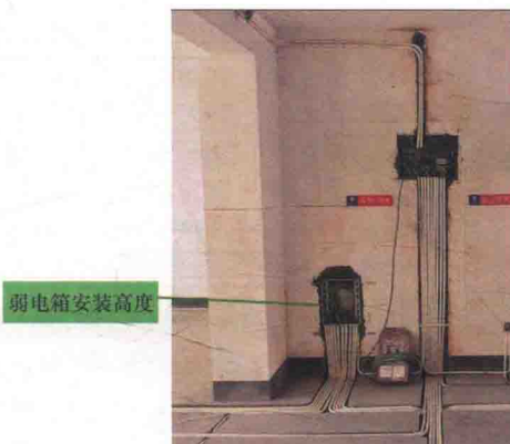
图 1-6 弱电箱安装高度图例
