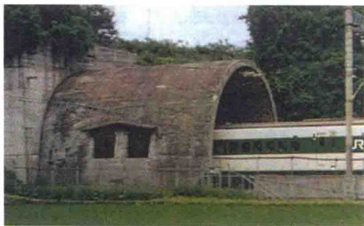
(b) 日本新干线两侧开窗型缓冲结构
