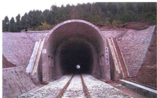
(a) 遂渝线隧道洞口缓冲结构
