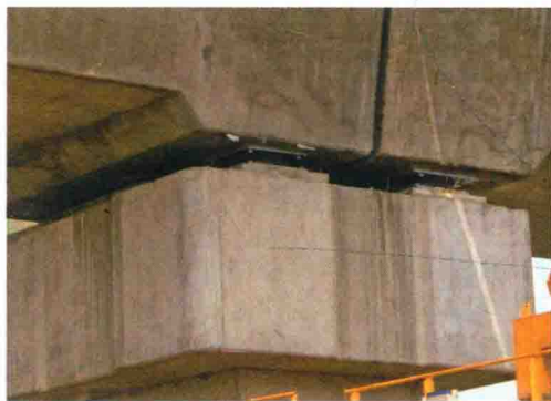
图 1-6 台湾高速铁路用减振支座
