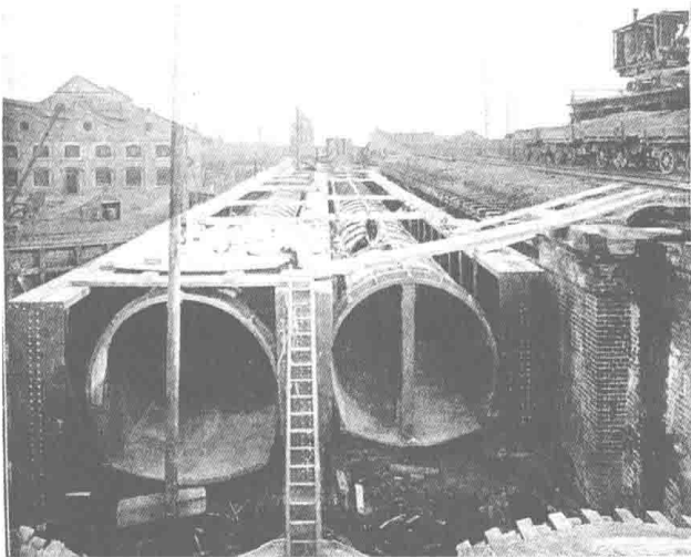
(a) 伦敦综合管廊兴建
