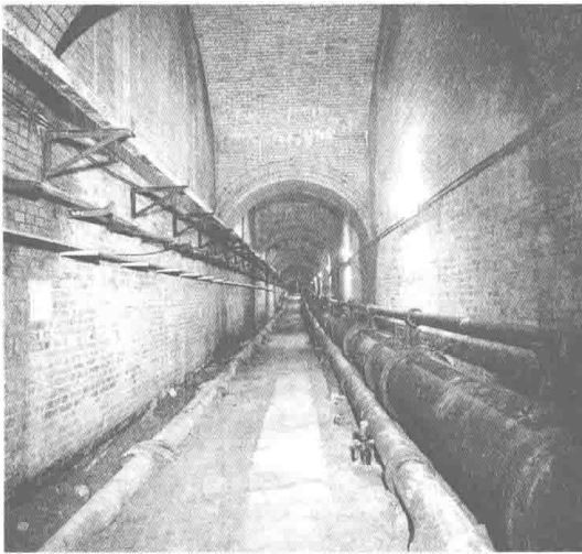
(b) 伦敦综合管廊内部实景
