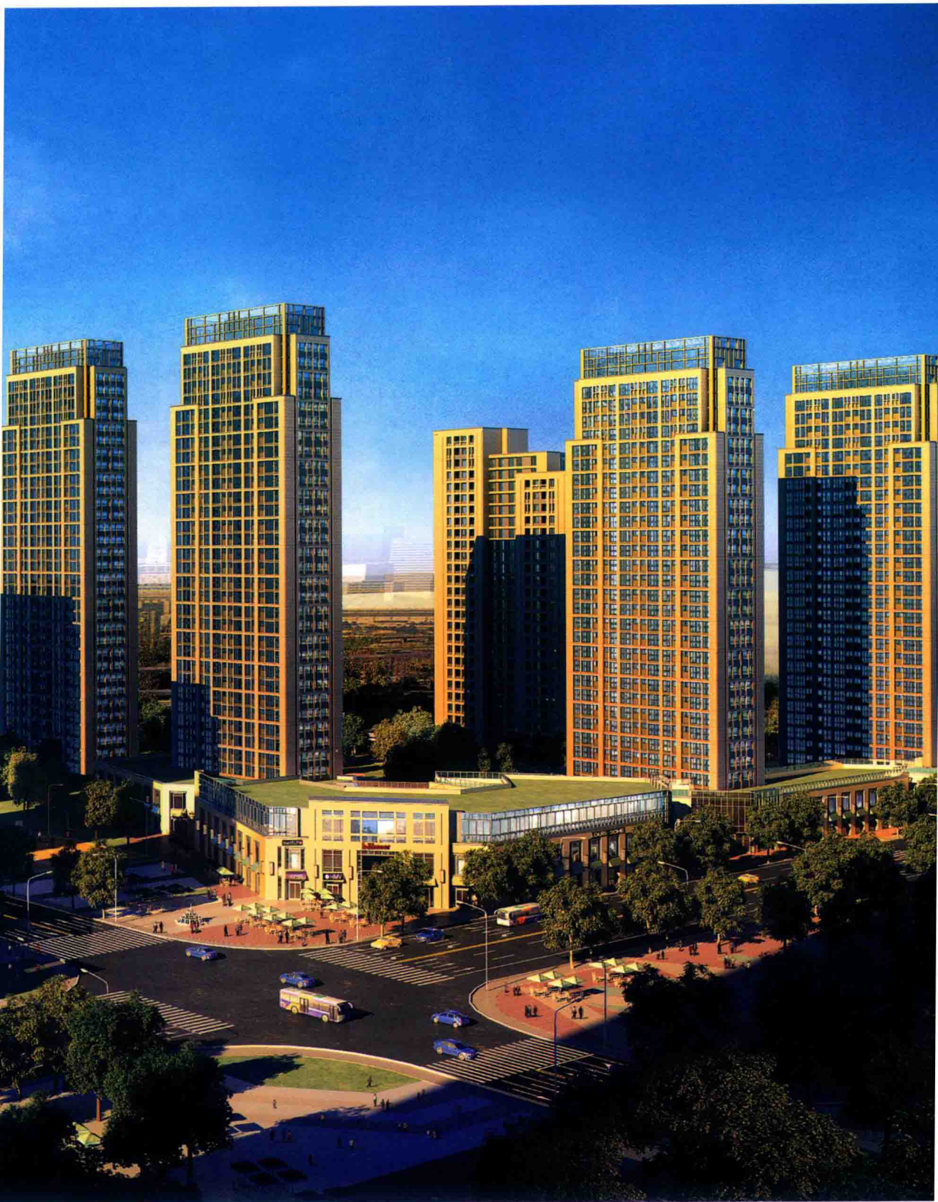
耀华地区19-1地块公共租赁住房项目
