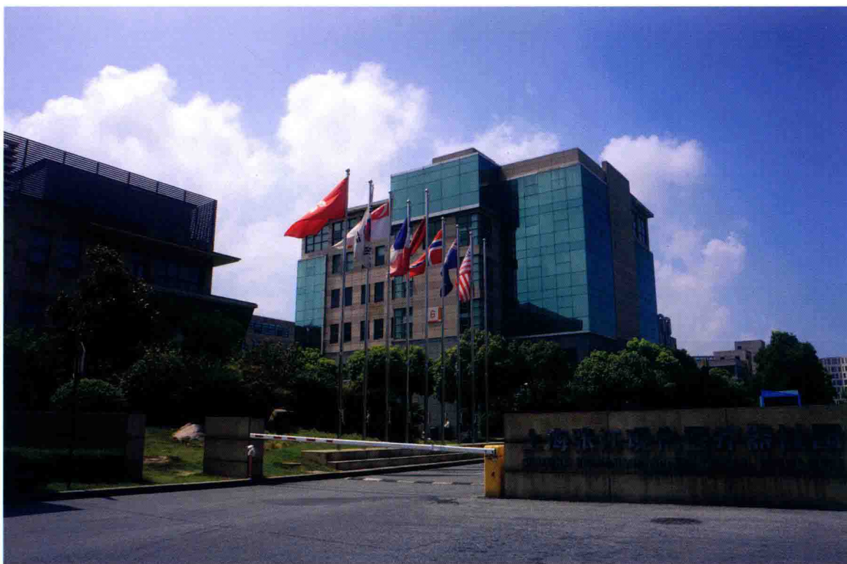
张江现代医疗器械园2号地块产业配套工程
