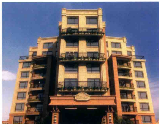
花木四季雅苑小高层内外装修工程
