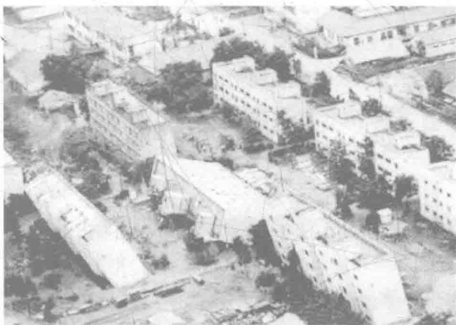
图 1.4 新潟地震中建筑物发生严重倾斜
