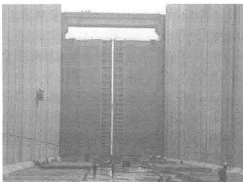
图 5-8 人字门船闸实例图
