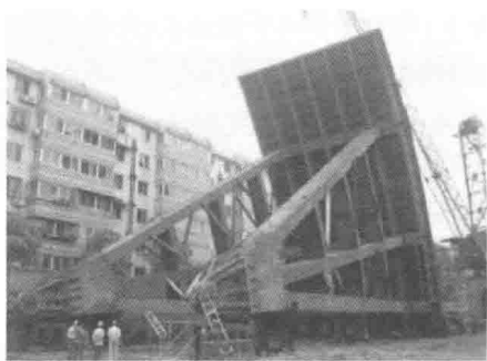
图 5-5 弧形闸门安装现场示意图
