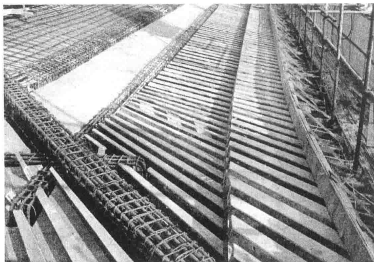
图 1-4 圆柱与斗拱、屋面支模现浇
