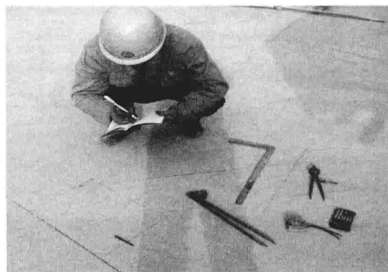
图 1-7 现场施工定位放线
