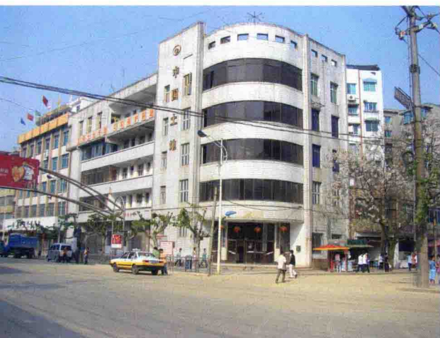
1991年10月修建的遵义县土地管理局大楼 (南园路口) (2007年7月摄)
