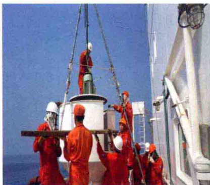
甲板设备吊装作业。
