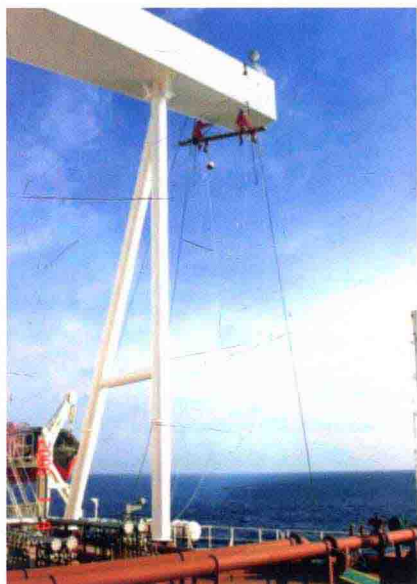
船容船貌维护保养作业（1）
