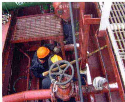
甲板设备维修作业。
