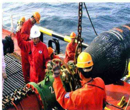
海上驳油接管作业。
