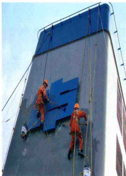
船容船貌维护保养作业（2）
