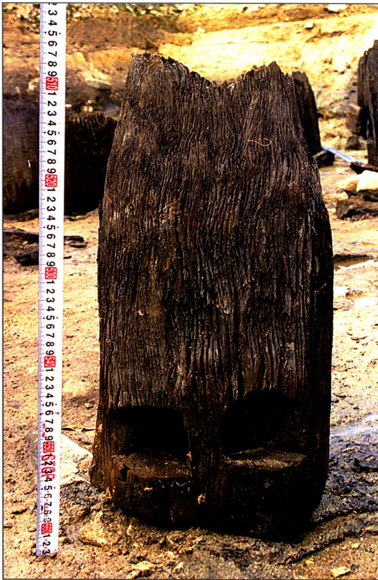
古建木桩的牛鼻形凿孔（图七）
