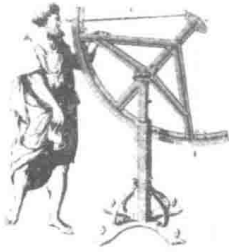
图 1-1 四分仪，测量角度的一种工具
