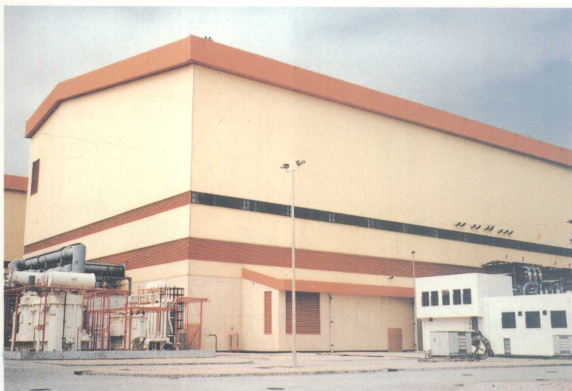
1# 常规岛厂房外貌
