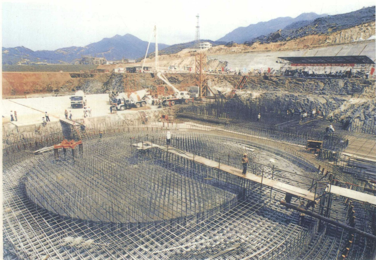
主体工程开工典礼
