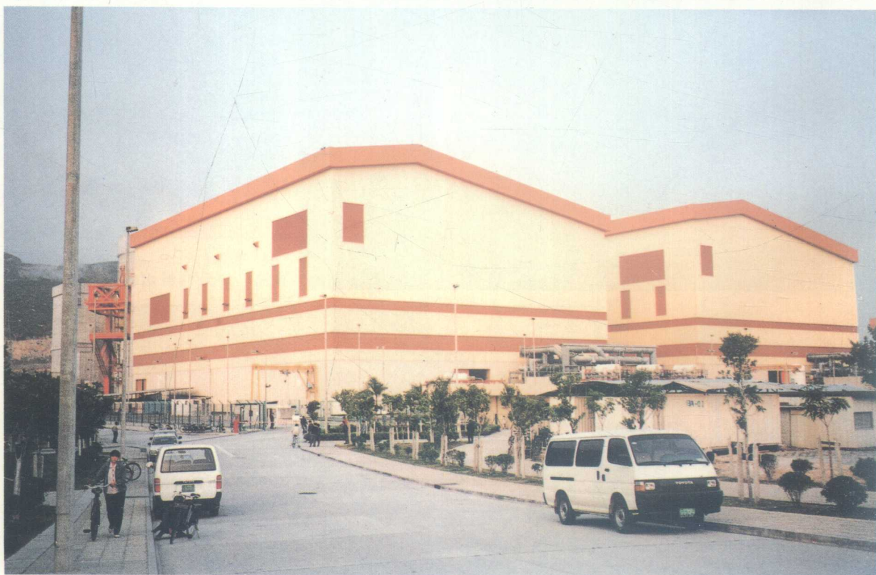
1# 和 2# 常规岛厂房全貌
