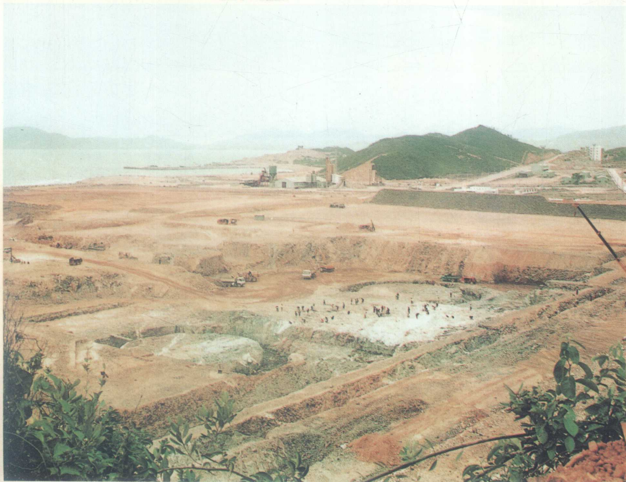
负挖工程之一
