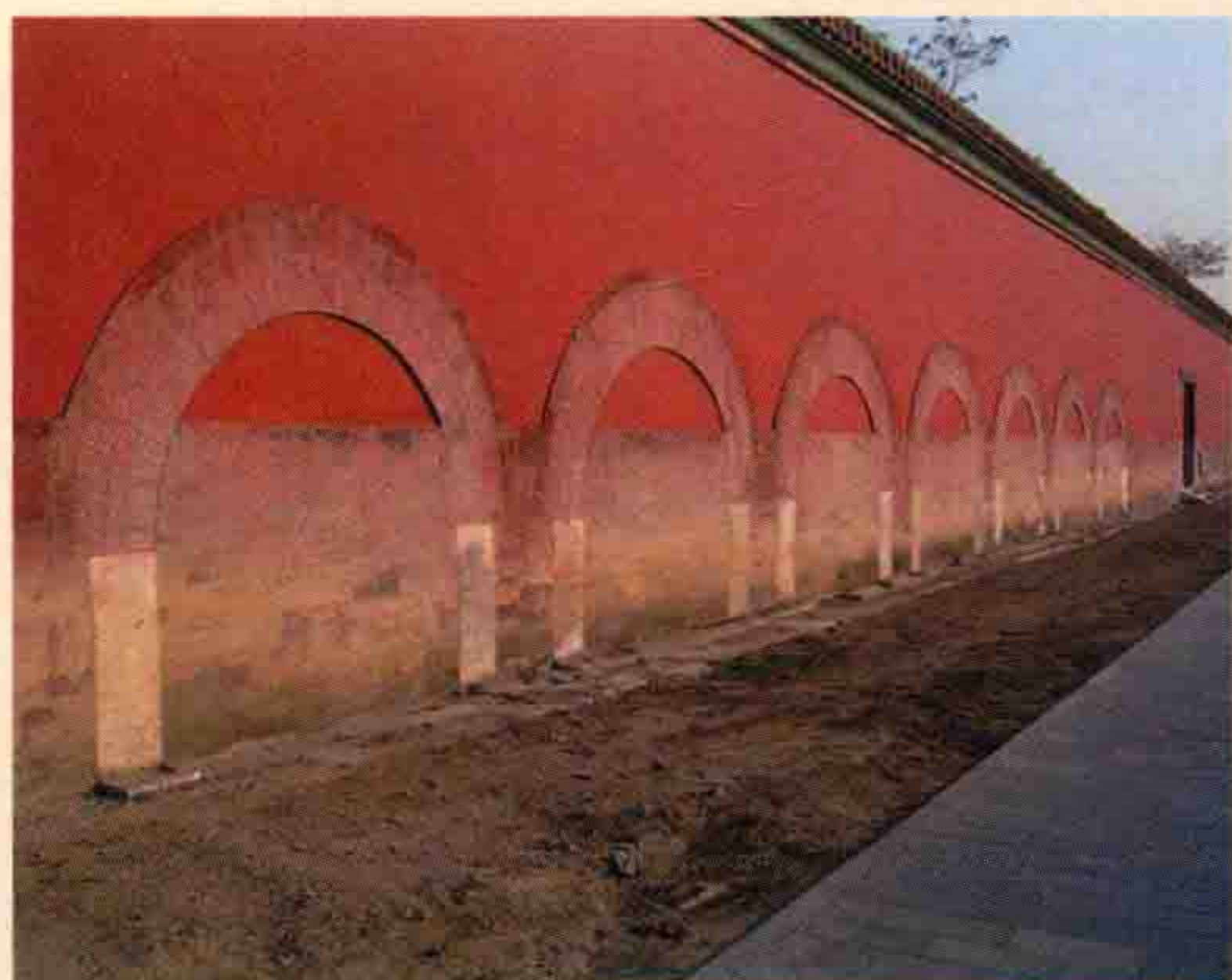
堆拔——现已被堵死，但券门仍在
