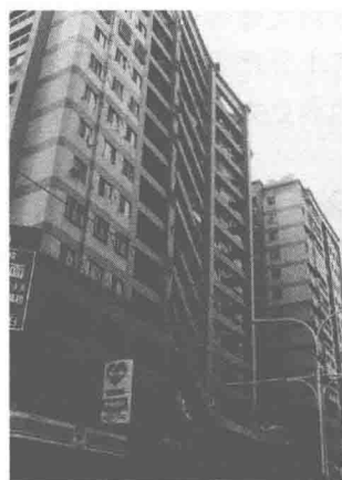
(a) 中国台湾南投县某高层建筑破坏
