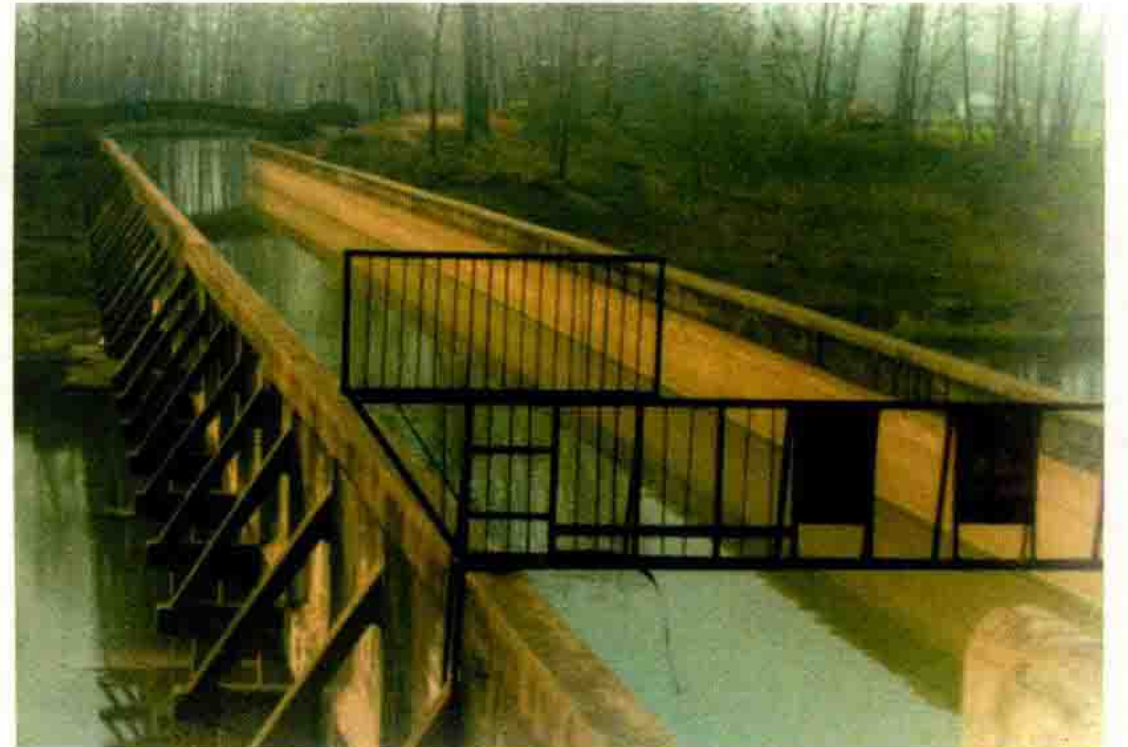
六塘河程道渡槽
