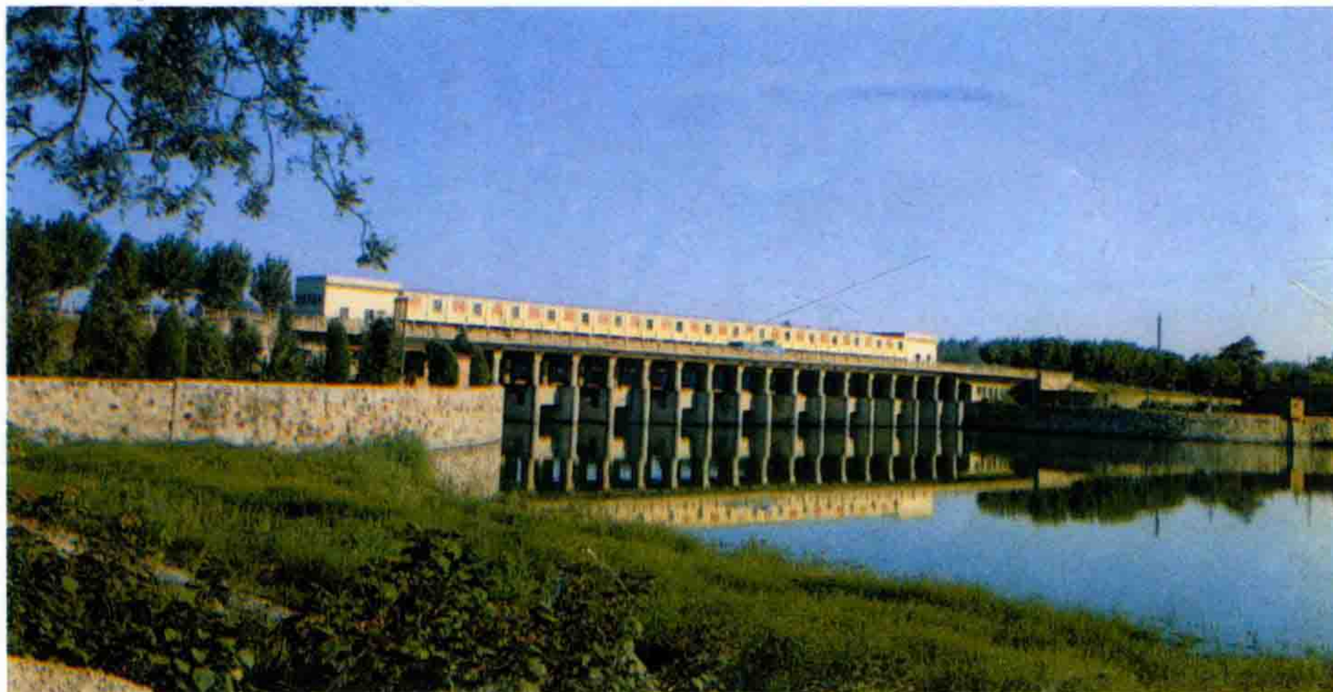
中运河泗阳节制闸
