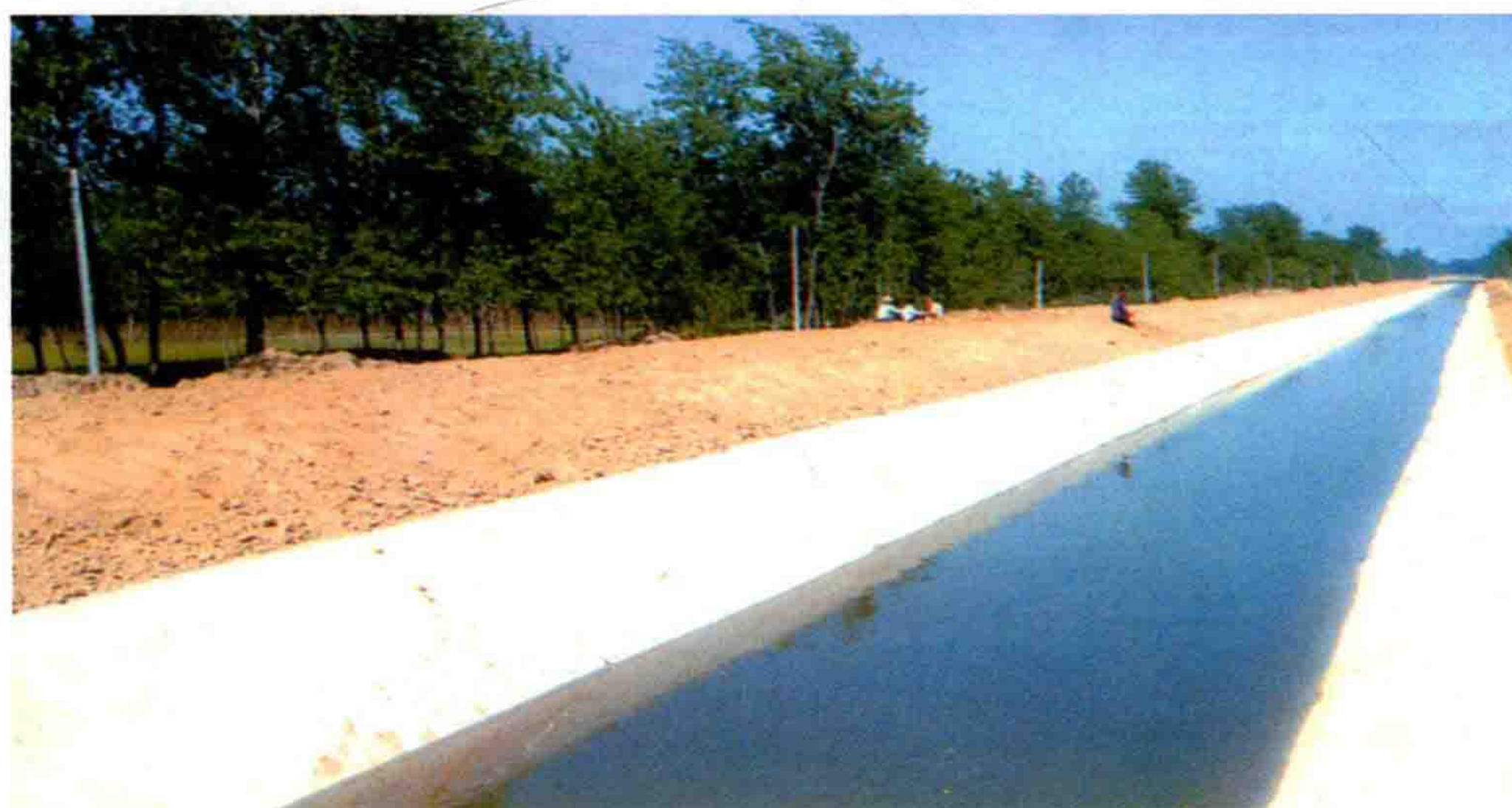
防渗渠道（八集支渠）
