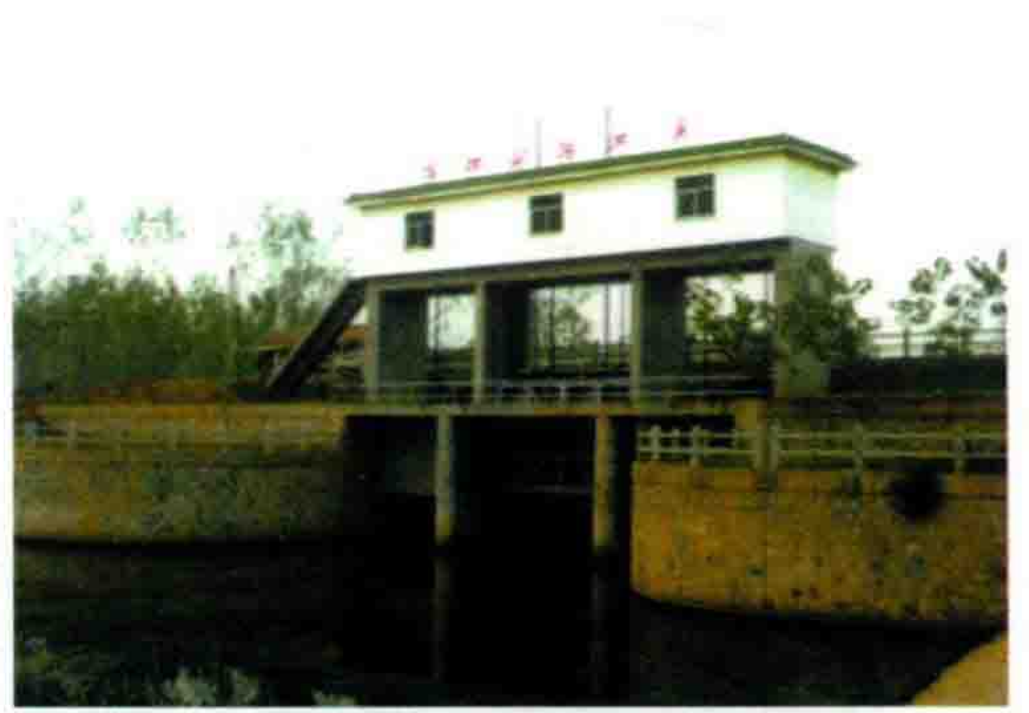
淮泗河挡洪闸
