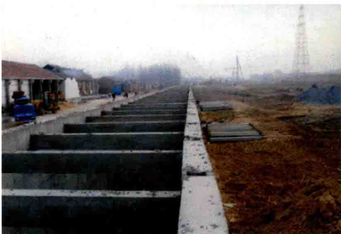
竹络坝干渠输水明渠
