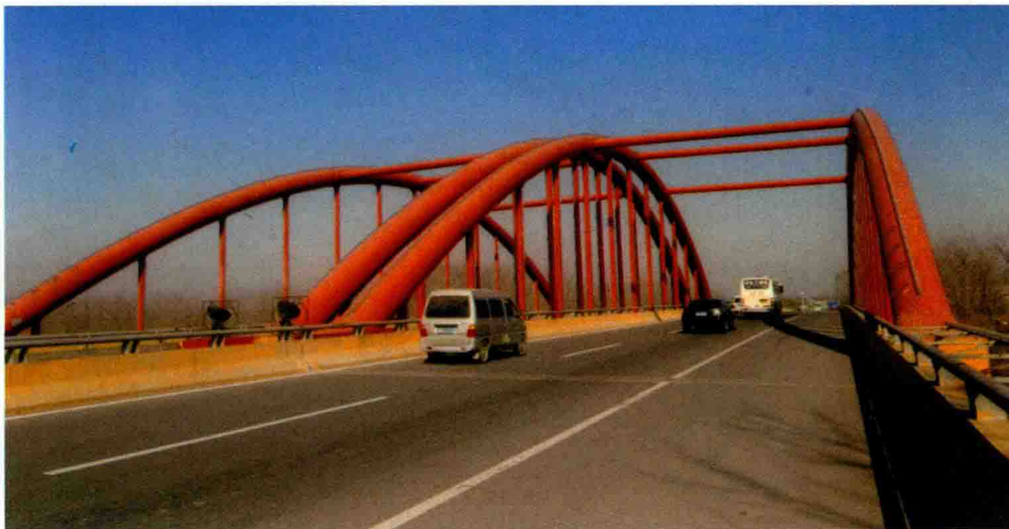
京杭运河泗阳二桥
