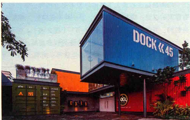
图 2-11 印度 45 号码头夜店的外部实景图, 该建筑的外立面设计采用的是集装箱单元的重组。在集装箱的重复使用上, 比例和尺度的把握尤为关键, 其设计是在建筑领域的完美表达
