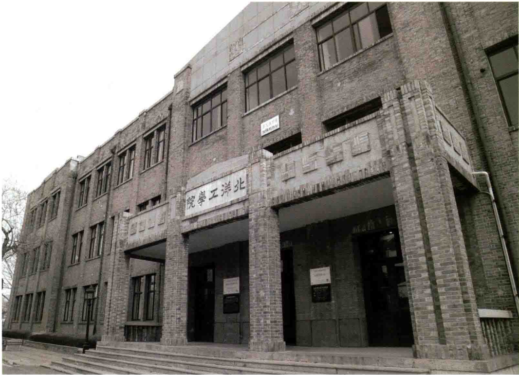
北洋工学院教学大楼旧址
