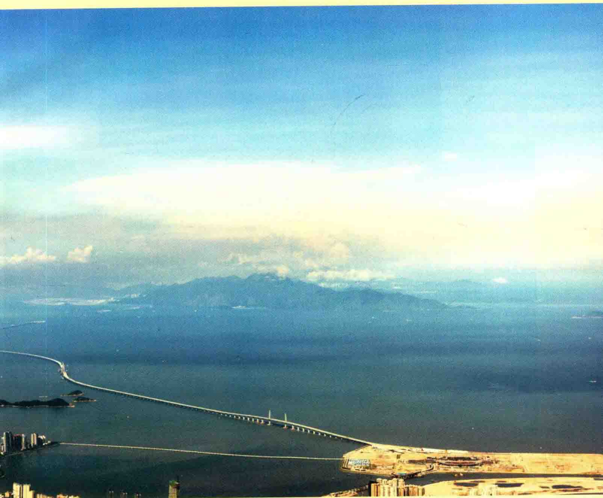
建设中的港珠澳大桥全景（杨瑶琼 摄）
