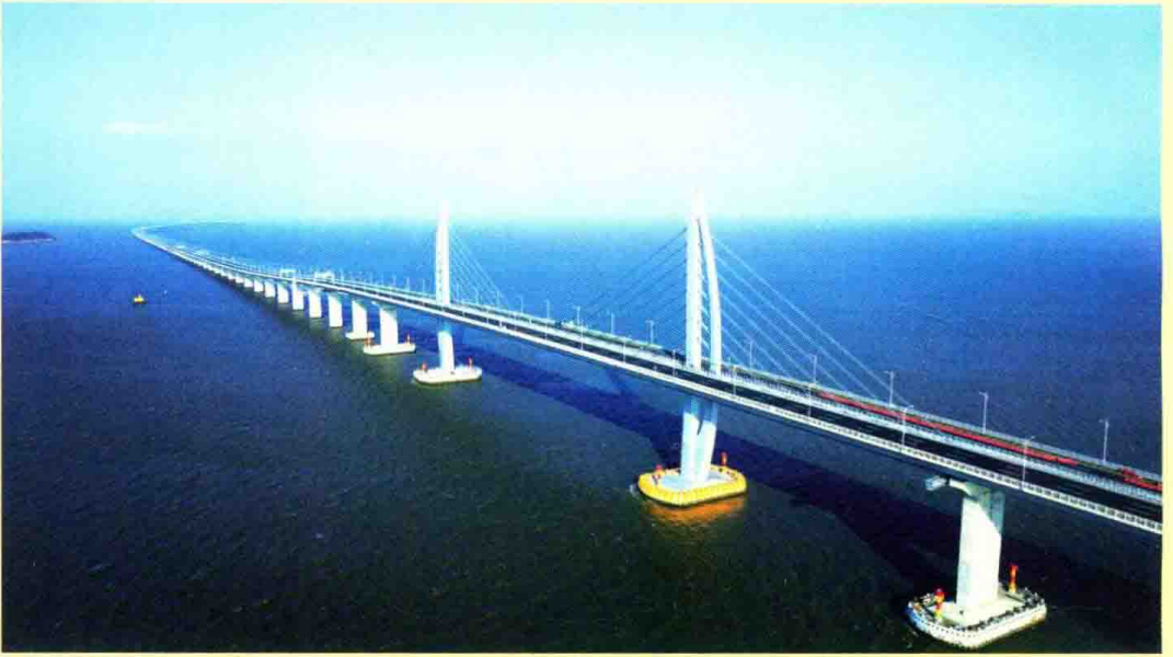
建设中的港珠澳大桥（港珠澳大桥管理局提供）
