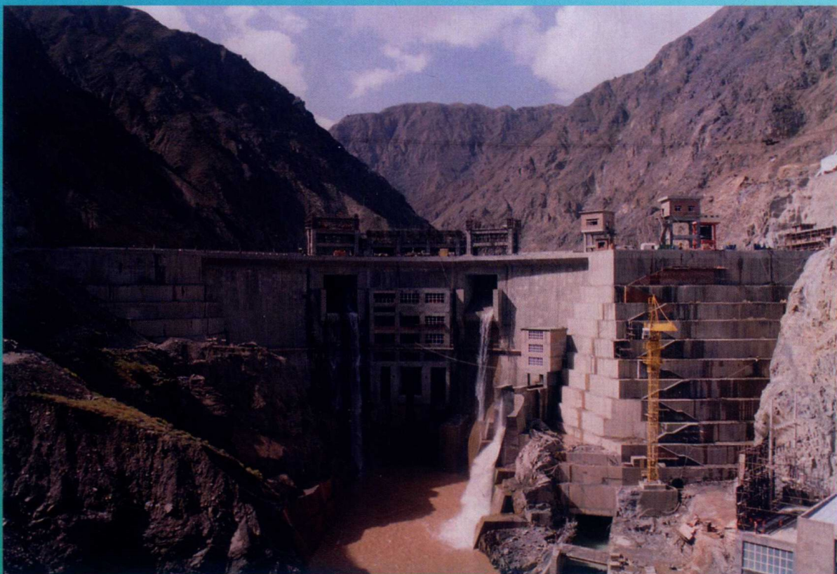
甘肃龙首水电站
