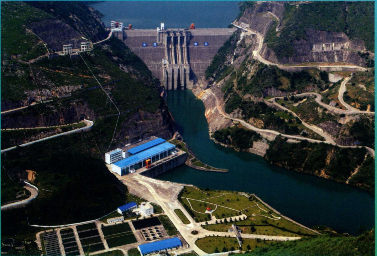
贵州光照水电站
