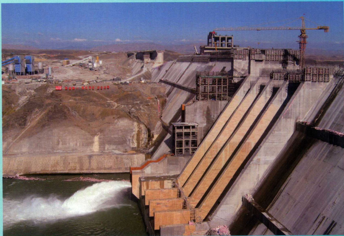
新疆喀腊塑克水电站
