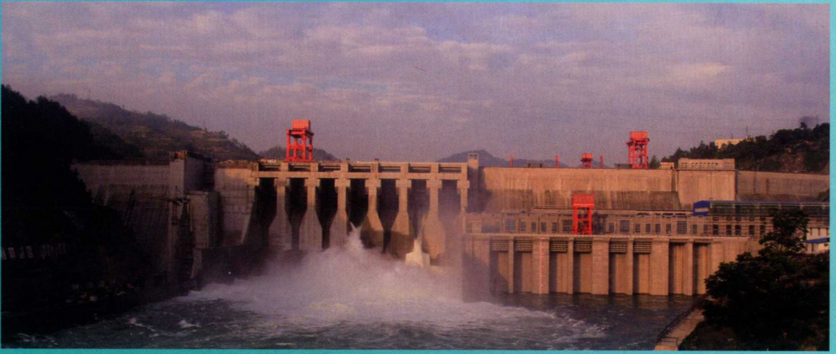
贵州沙沱水电站
