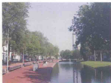
彩图 4-48 混凝土和草坡驳岸 (丁绍刚摄)
