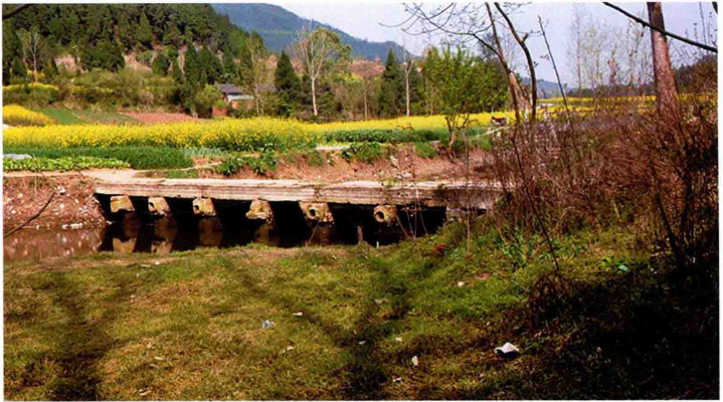
蓬安乡间石桥
