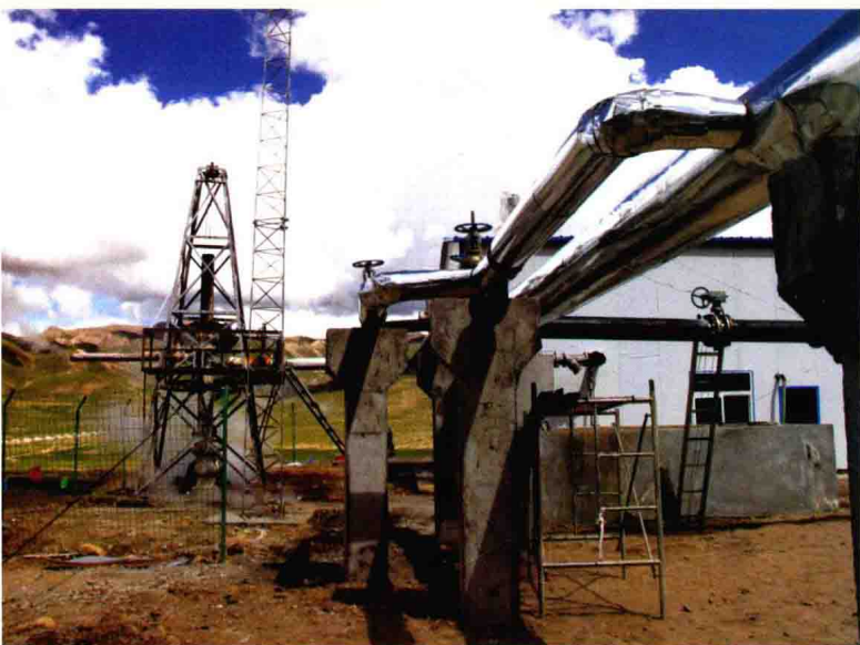
▼ 华北留北油田建成的 400kW 双工质螺杆机地热发电
