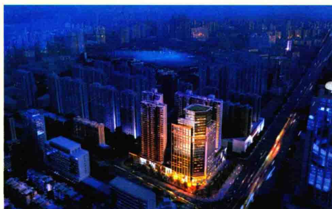
◀ 武汉市政府深得民心的“冬暖夏凉工程”实施地源热泵供暖制冷，这是 13 万 m^2 的海山金谷项目（陆特能源提供）
