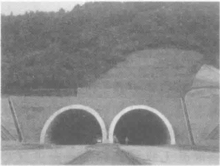
g) 隧道工程
