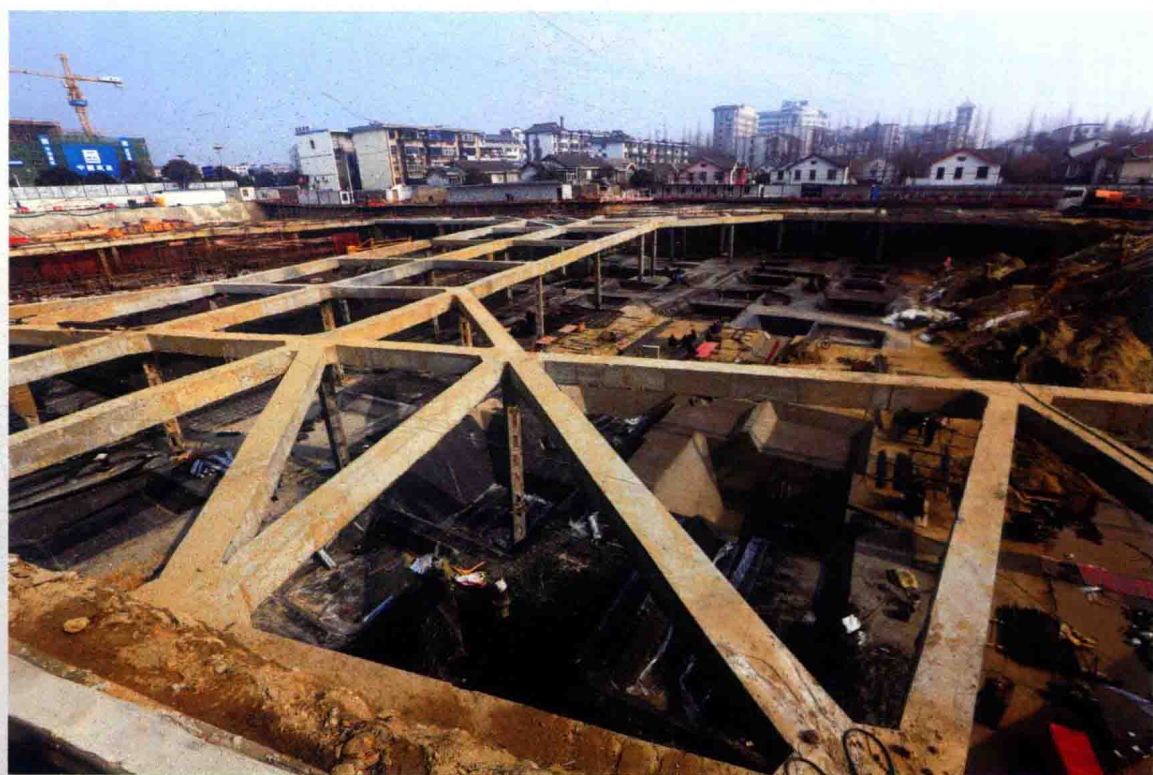
基坑支护结构
