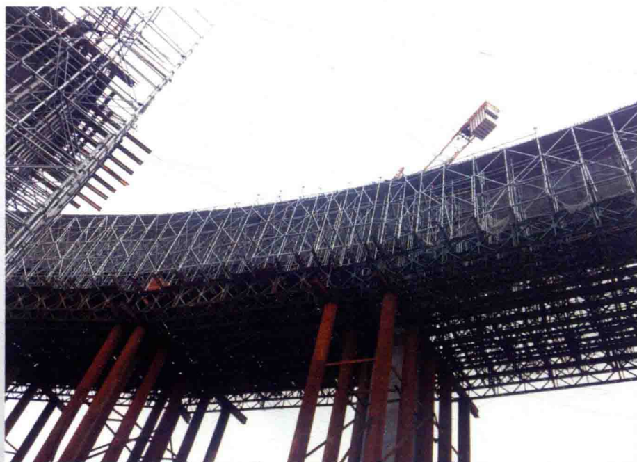
现浇箱梁钢管贝雷盘支组合支架
