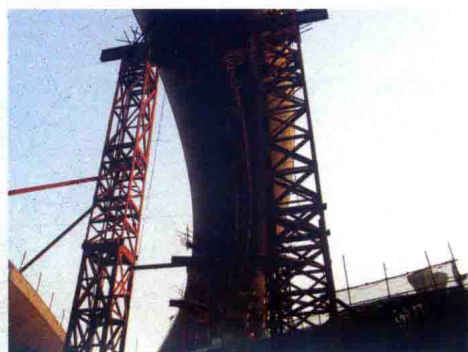
立交桥钢箱梁钢管安装支架
