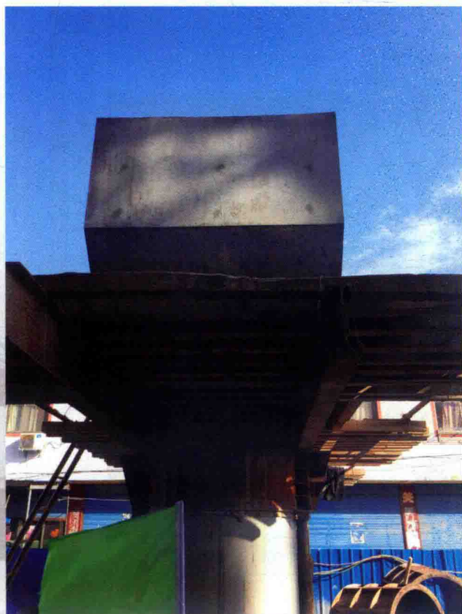
桥墩盖梁施工支撑
