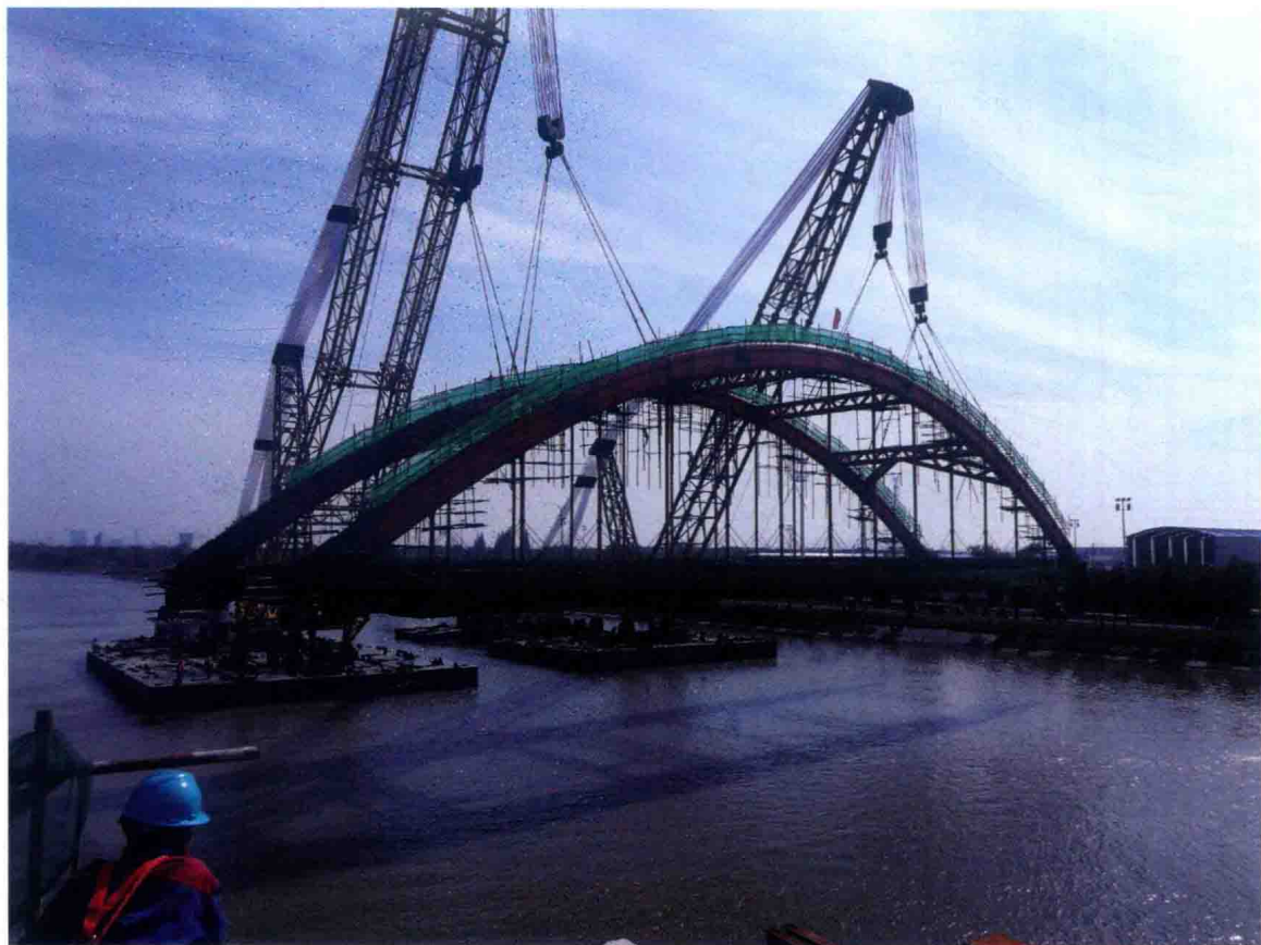
浮吊安装系杆钢管拱肋及劲性骨架
