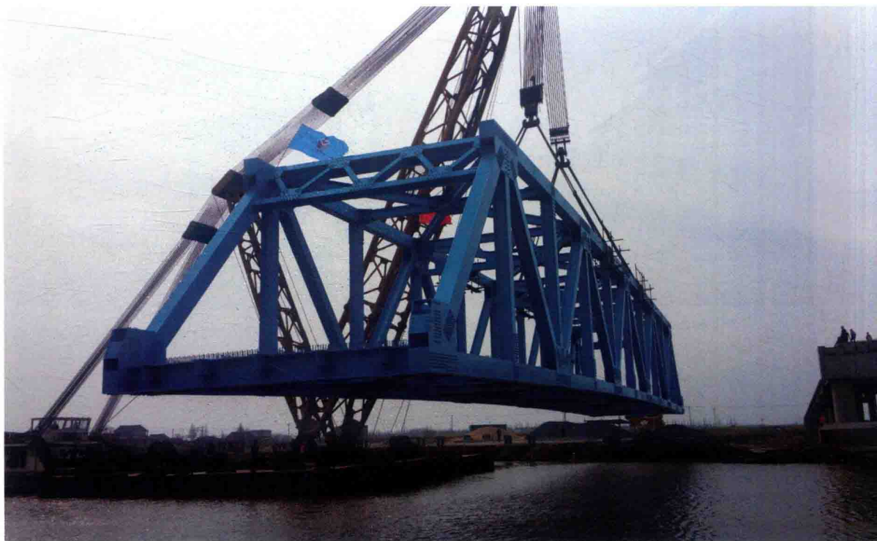
浮吊安装钢桁梁
