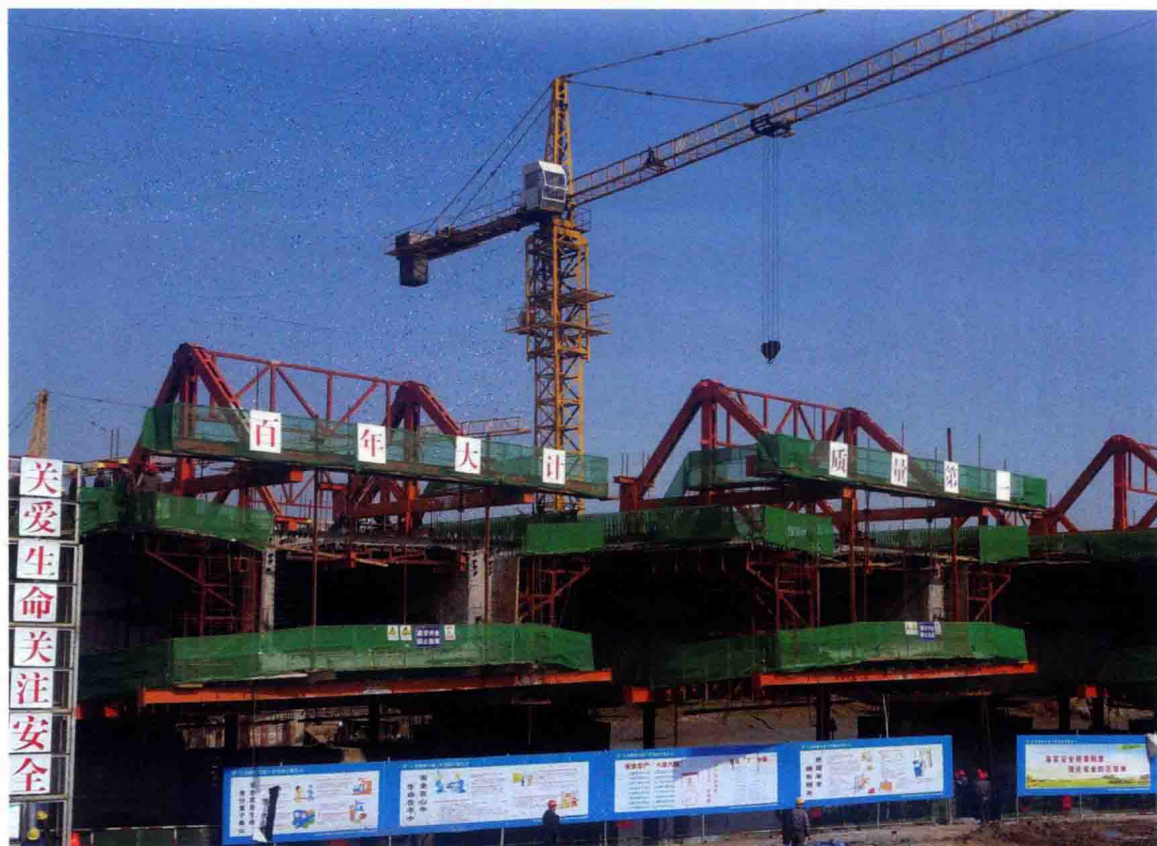
连续梁悬挂篮
