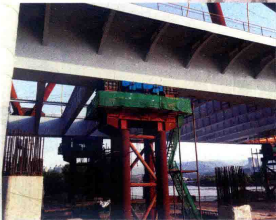
桥梁顶推施工支墩
