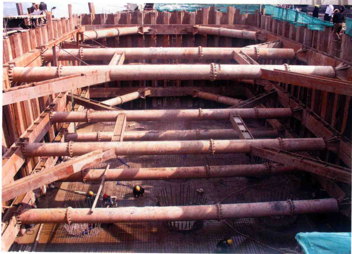
承台钢板桩围堰
