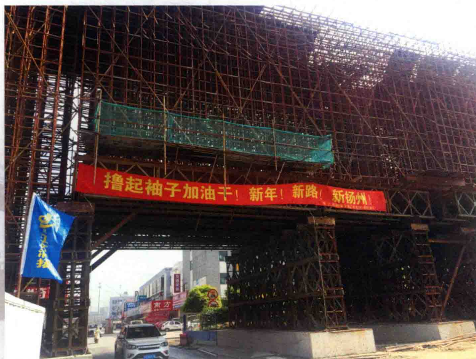
现浇箱梁门洞 支架
