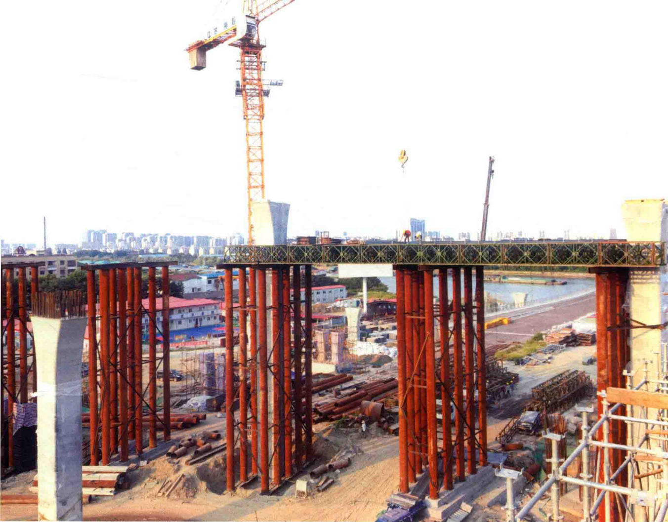
现浇箱梁钢管贝雷支架
