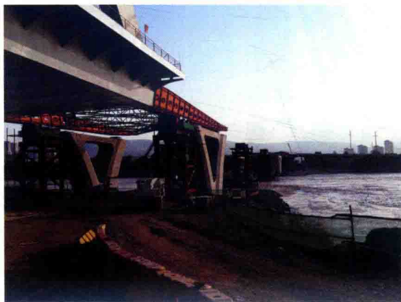
桥梁顶推施工导梁
