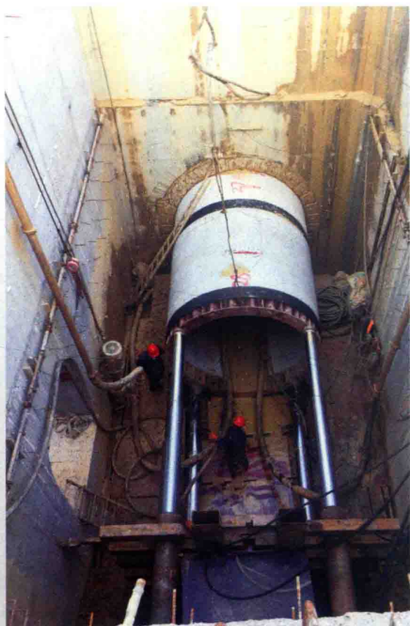
顶管钢筋混凝土工作井
