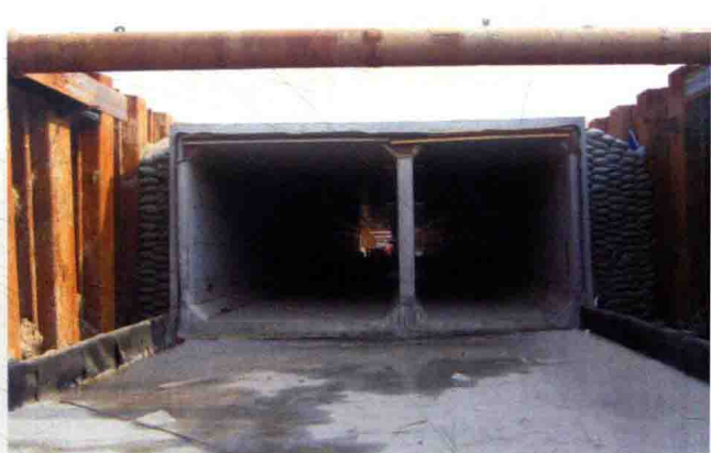
管廊施工钢板桩支护
