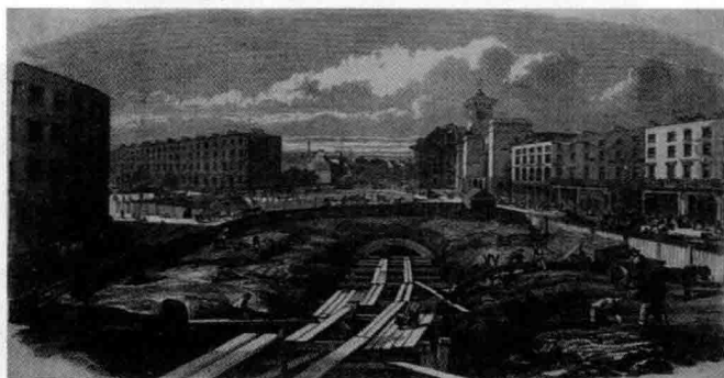
图 1.4 伦敦地铁修建场景
