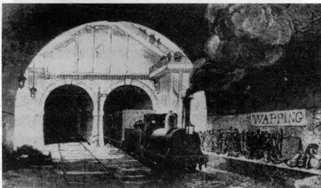
图 1.5 1869 年伦敦地铁的泰晤士隧道开通
