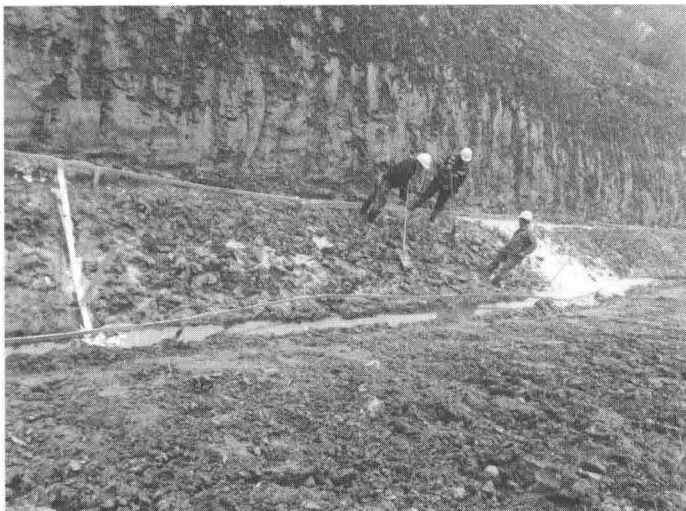
图 1-8 施工中的明挖隧道接地网
