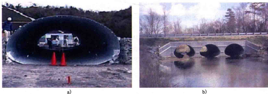
图 1-1 金属波纹管涵
