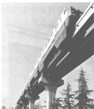
图 1.2-1 重庆 3 号线简支轨道梁桥实景图
