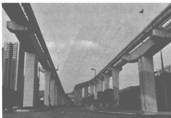
图 1.2-2 重庆 3 号线出入段线简支轨道梁桥实景图
