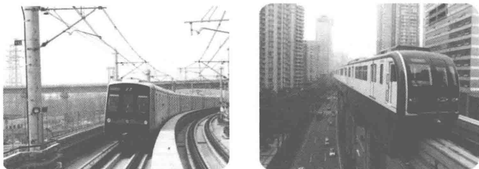
图 1.1-12 跨座式单轨线路无架空接触网
