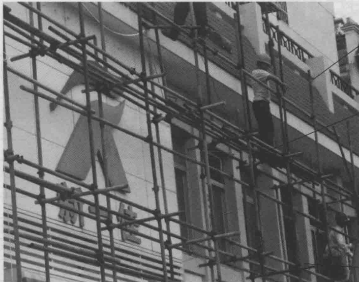
扣件式钢管脚手架
