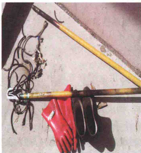
图 1-1 被烧毁的地线及操作杆
