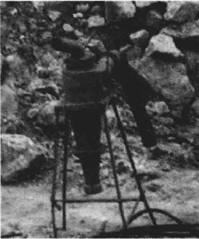
图 1.2-4 施工现场泥浆旋流器
