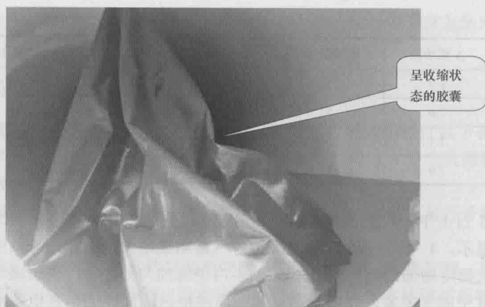
图 1-6 人孔盖打开后储油柜的内部
