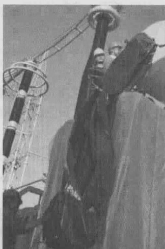
图 1-7 取出储油柜胶囊
