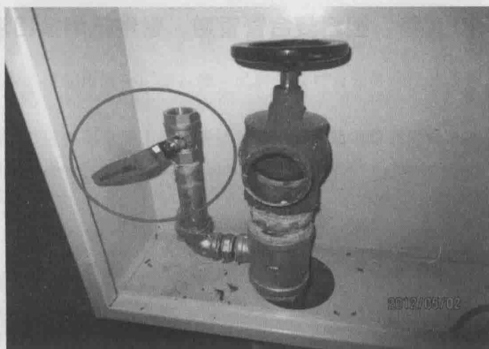
图 1-5 阀门无法正常开启
