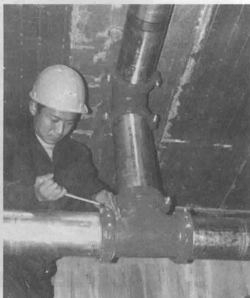
图 1-12 卡箍螺栓受力均匀
