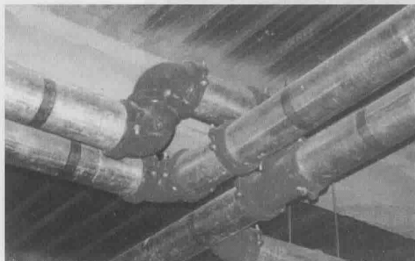
图 1-11 卡箍安装无缝隙
